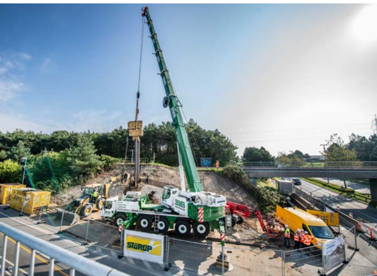
Gjesing Station ved Bilka i Esbjerg under ombygning.
